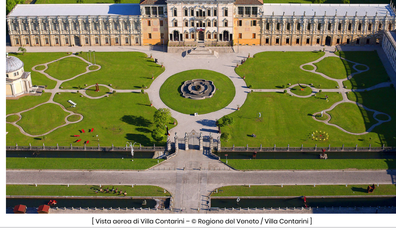
[ Vista aerea di Villa Contarini – © Regione del Veneto / Villa Contarini ]
